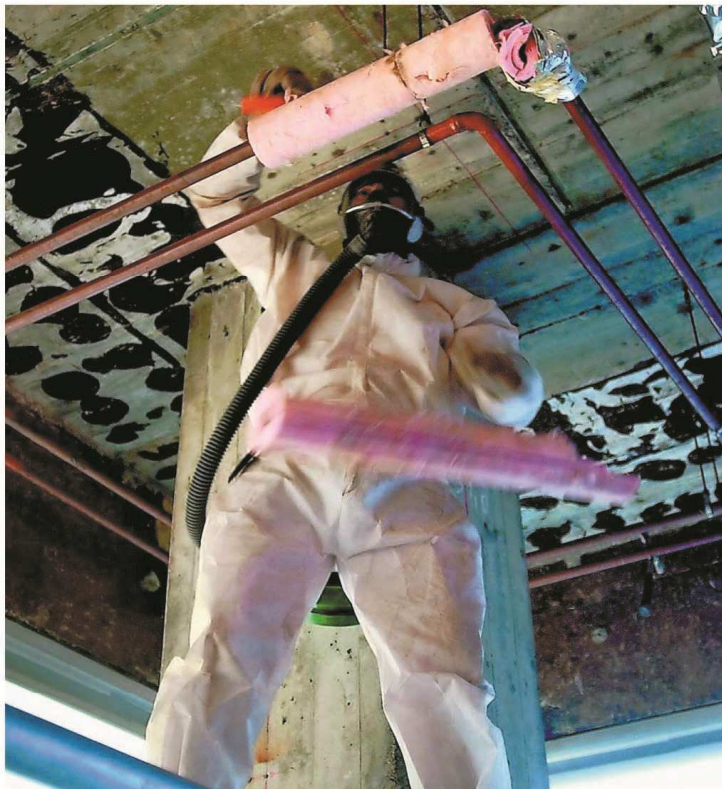
Asbestsanierung: Der krebserregende Werkstoff darf nur mit Schutzkleidern und Atemmaske entfernt werden. KEY
